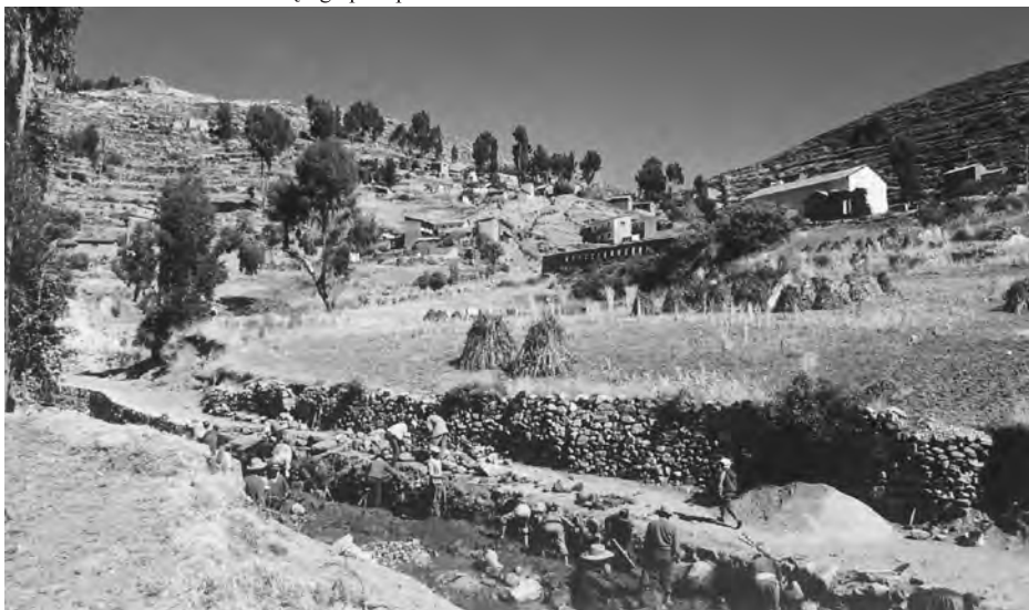
Belen — budowa wału chroniącego pola przed zalaniem
